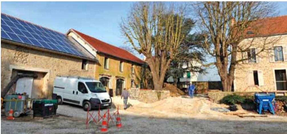
La Grande Ferme en chantier : à gauche le hangar agricole recouvert de panneaux solaires, qui abritera la médiathèque ; à droite, l'ancienne maison de maître, siège de la Maison des cultures et des arts.
